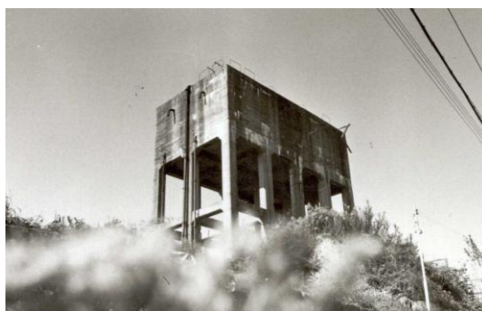
〔創設時の配水池〕
