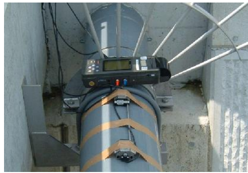
流量調査状況(超音波流量計)
