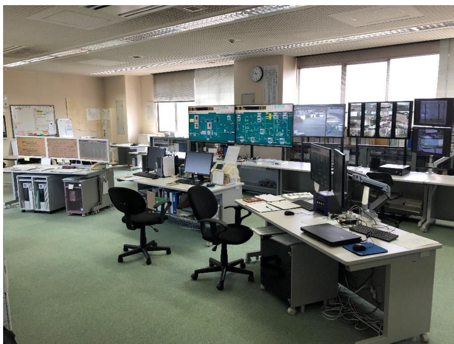
水道管理センター中央監視室 (石川浄水場内)
