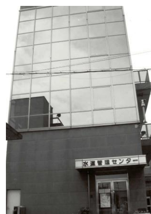
〔水道管理センター〕
