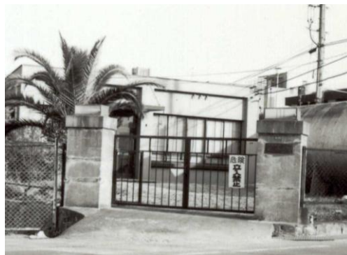
〔羽曳山配水場〕
