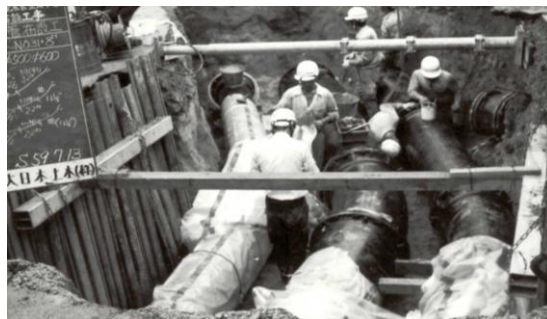
〔配水管布設工事 φ400・φ600・φ500〕
