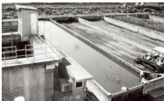
〔石川浄水場汚泥処理設備〕
