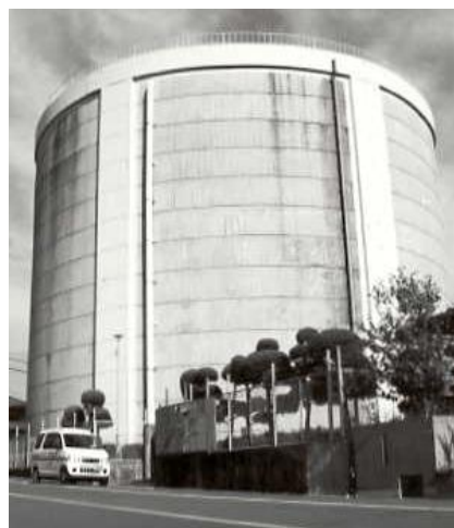
〔高区配水池〕(平成21年解体撤去)
