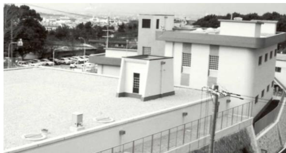
〔羽曳山配水場〕
