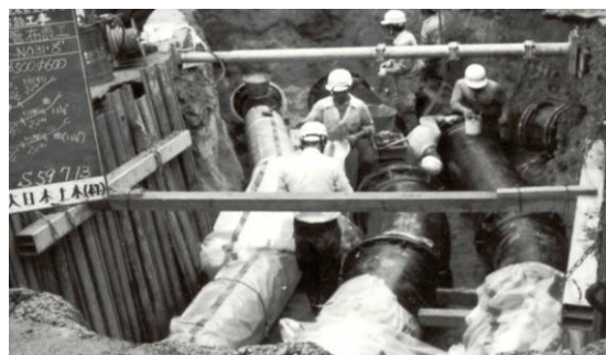
〔配水管布設工事 φ400・φ600・φ500〕
