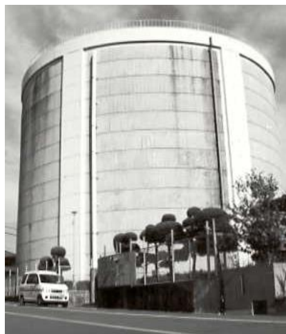
〔高区配水池〕(平成21年解体撤去)
