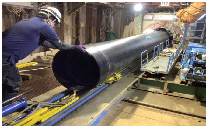
〔伊賀受水場低区第2配水池送水管改良工事〕
