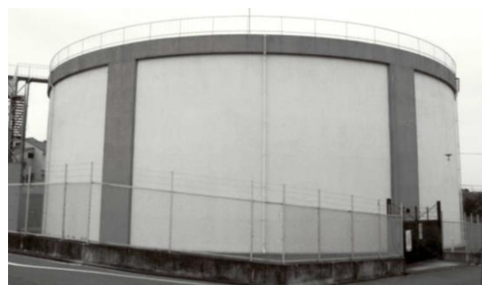
〔低区第2配水池〕
