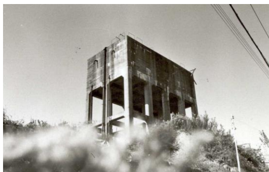
〔創設時の配水池〕
