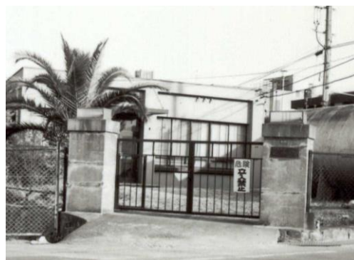
〔羽曳山配水場〕
