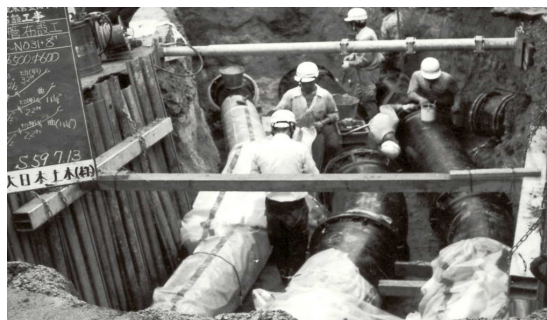
〔配水管布設工事 φ400・φ600・φ500〕
