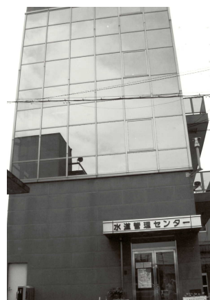
〔水道管理センター〕
