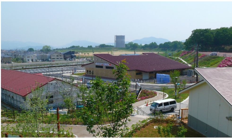
道の駅 しらとりの郷・羽曳野（高区配水池）
