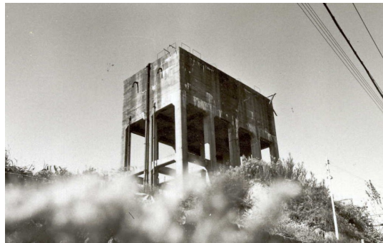
〔創設時の配水池〕
