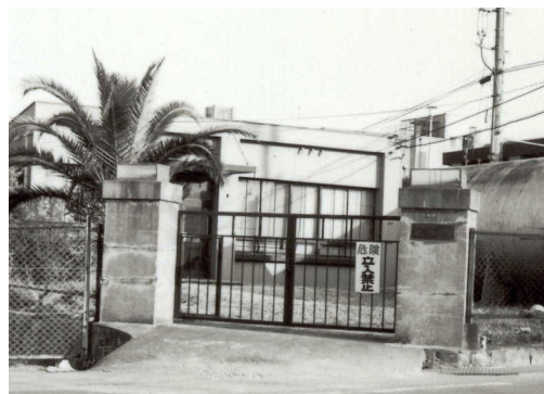
〔羽曳山配水場〕
