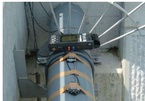
流量調査状況(超音波流量計)
