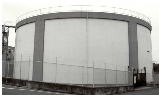
〔低区第2配水池〕
