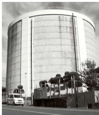
〔高区配水池〕(平成21年解体撤去)
